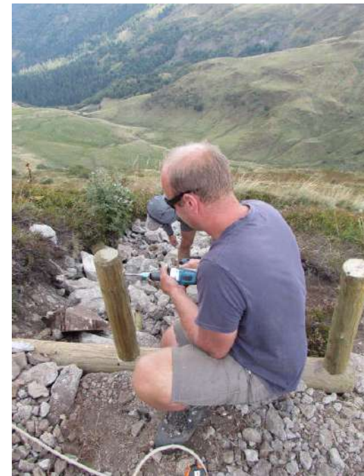
Mise en place de la main courante
