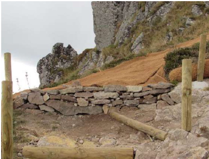
Réalisation de muret
