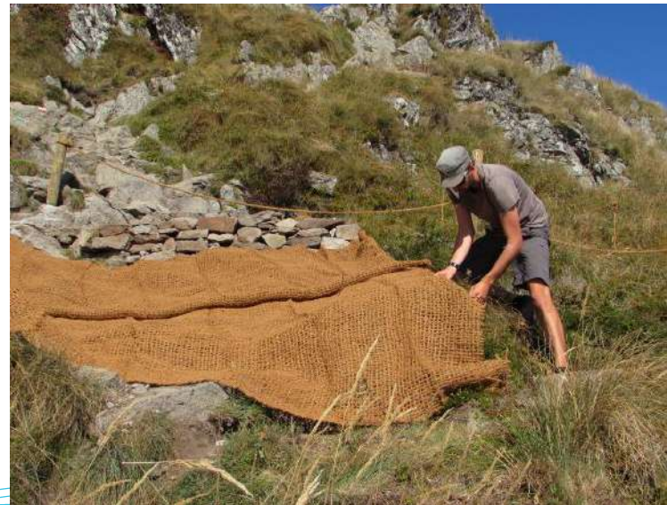
Pose de toile géotextile
